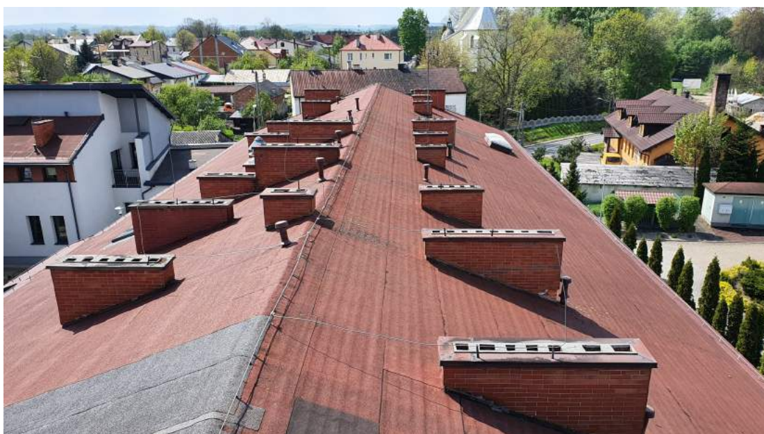
Stan techniczny budynku - zadowolający.
